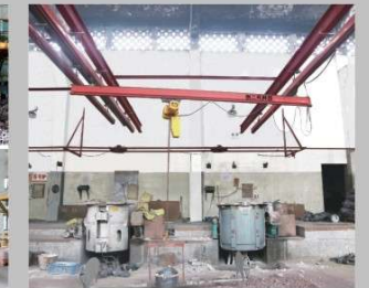
▲ Pouring Line 轻型轨道浇筑线
